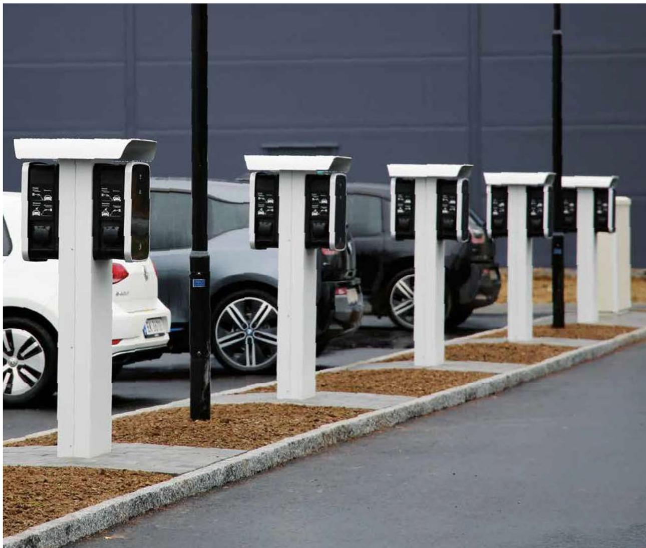
Con l'ausilio del nuovo software ABL è possibile collegare tra di loro e azionare in modo intelligente i punti di ricarica di più Wallbox eMH3
